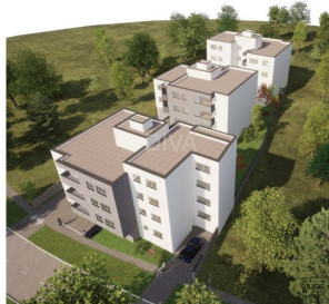
STAMBENA ZGRADA STROSS 79 Ulica 2.2. Samostanskega 79, Slavonski Brod
